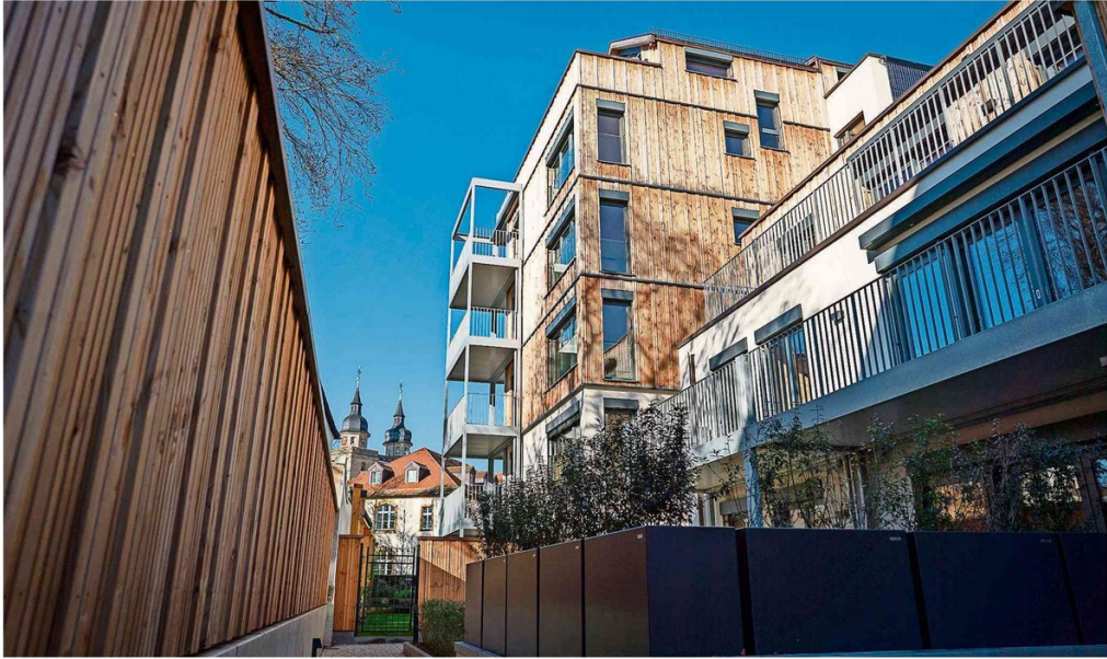
Versteckt im Hinterhof, direkt angebaut an das Gebäude der Regierung – und ein Leuchtturm an Nachhaltigkeit: Das mit fünf Stockwerken höchste leimfreie Holzhaus Bayerns, das in Bayreuth jetzt bundesweites Interesse fand.
