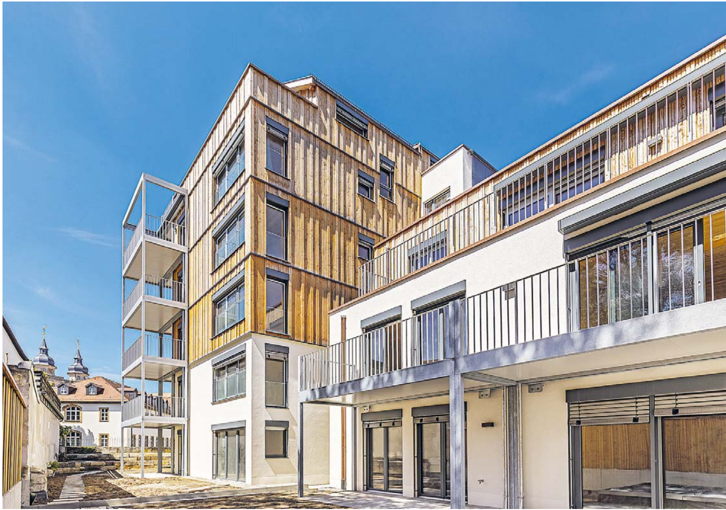
Wohnungsneubau in Bayreuth: Die beiden Gebäude im Zentrum der oberfränkischen Stadt wurden in leimfreier Massivholzbautechnik errichtet.
